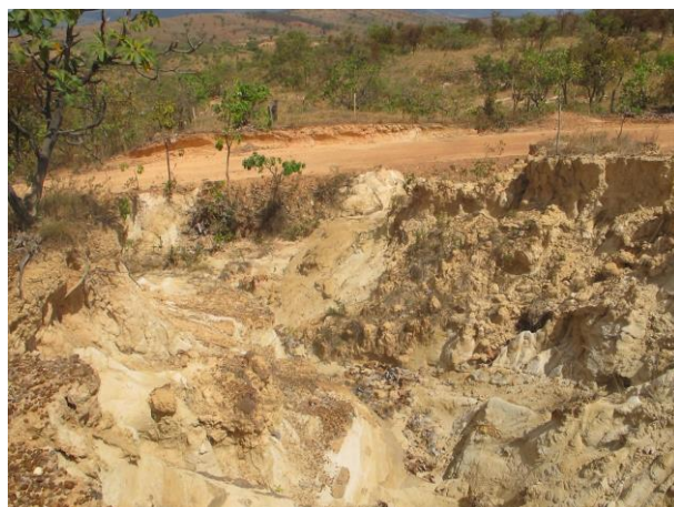
Foto 18: Voçoroca existente no município de Buenópolis. – 17/10/16
