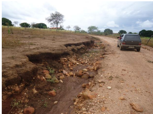
Foto 14: Área com focos de erosão no bordo da estrada vicinal no município de Augusto de Lima. – 05/07/16
